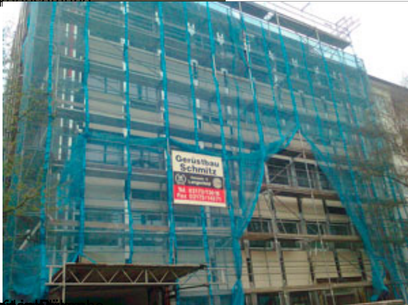
Rehabilitationsarbeiten für ein Bürohaus in Düsseldorf
