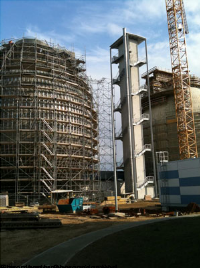
Ständergerüst am Georgenrathbock
